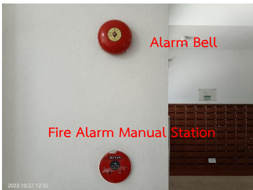
Fire Alarm Manual Station และ Alarm Bell
